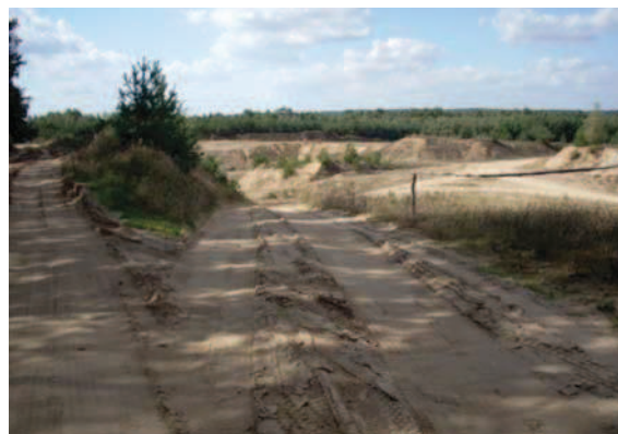
FOT. 13 Brak oznaczenia dopuszczalnej prędkości poruszania się pojazdów mechanicznych po drogach oraz brak tablicy ostrzegawczej o zakazie wjazdu na teren zakładu osób nieupoważnionych
